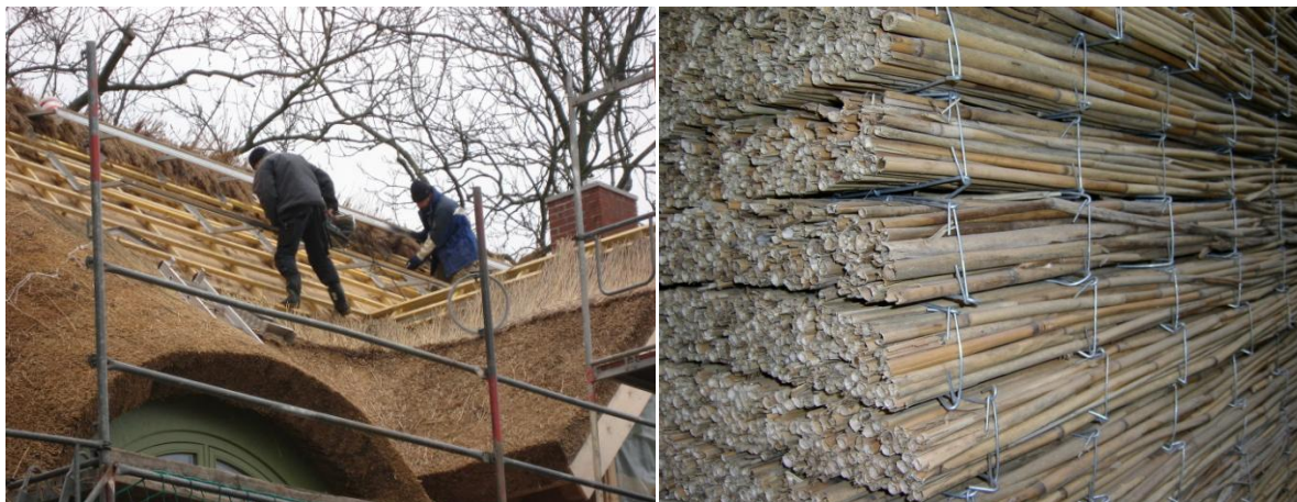
Abb. 1. Traditionelle Verwertung von Schilf als Dachreet und Schilfmatten zur Dämmung (Fotos: F. Tanneberger, S. Wichmann).
